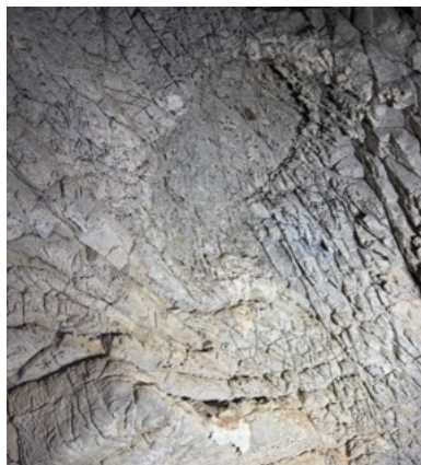
Fig.16 : coupole engendrée par la biocorrosion. On remarque des figures faisant penser à de l'éléphant skin. Photo LBQ
