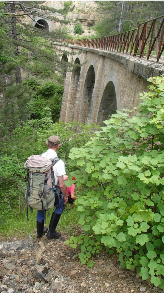
Viaduc à proximité de la grotte de Sainte-Hélène sur la ligne du Translozérien : Mende - La Bastide Saint-Laurent construite en 1902.
