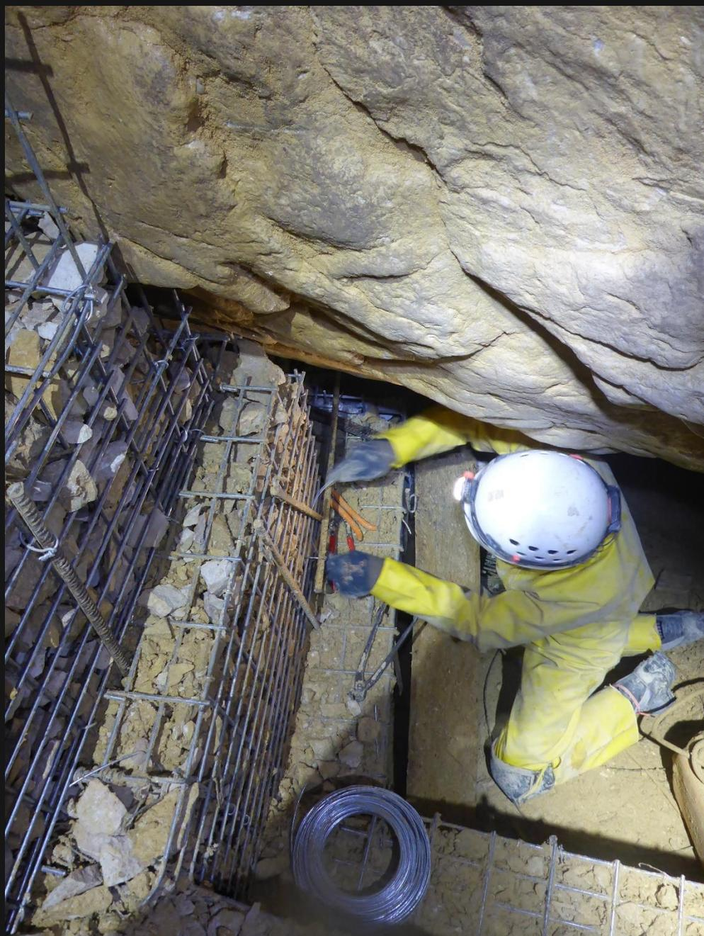
**La Balme à Collomb, Massif de la Chartreuse.** Photo Jacques Nant le 29/09/2018. Vue d'ensemble des 6 gabions en pied de trémie (éboulis gorgé d'argile semi-liquide) et en sortie du boyau d'accès. Travaux en cours du Spéléo Club de Savoie.
